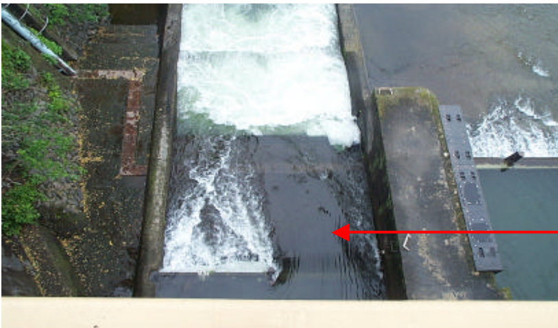
魚道出口は、コンクリートで埋められ水深が小さく高速流より遡上困難 (坂東橋より下部の魚道を見る)
