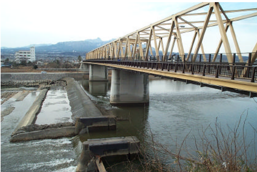
魚道出口は、コンクリートで埋められ水深が小さく高速流より遡上困難 (坂東橋より下部の魚道を見る)
