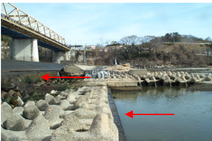
水が少ない時の坂東大堰 段差（矢印）が 2 段見える。
