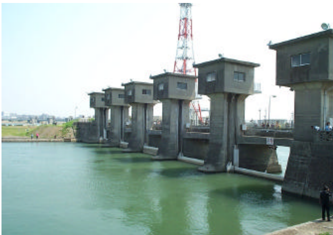
江戸川水門を上流側から見る
