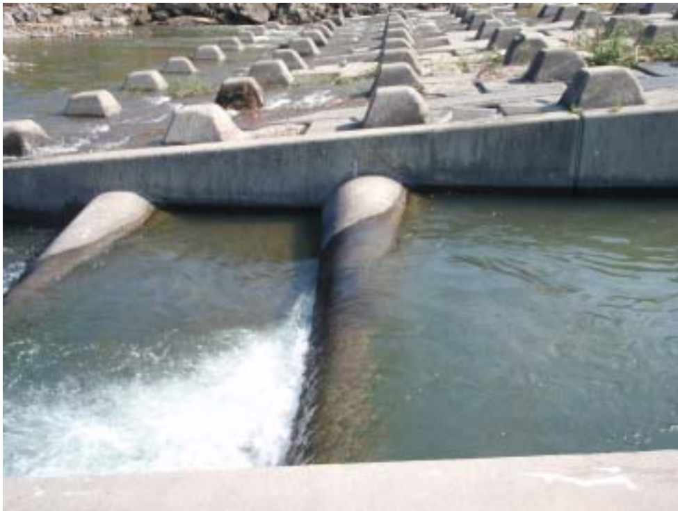
(上の写真：隔壁を半円形断面としている例)
