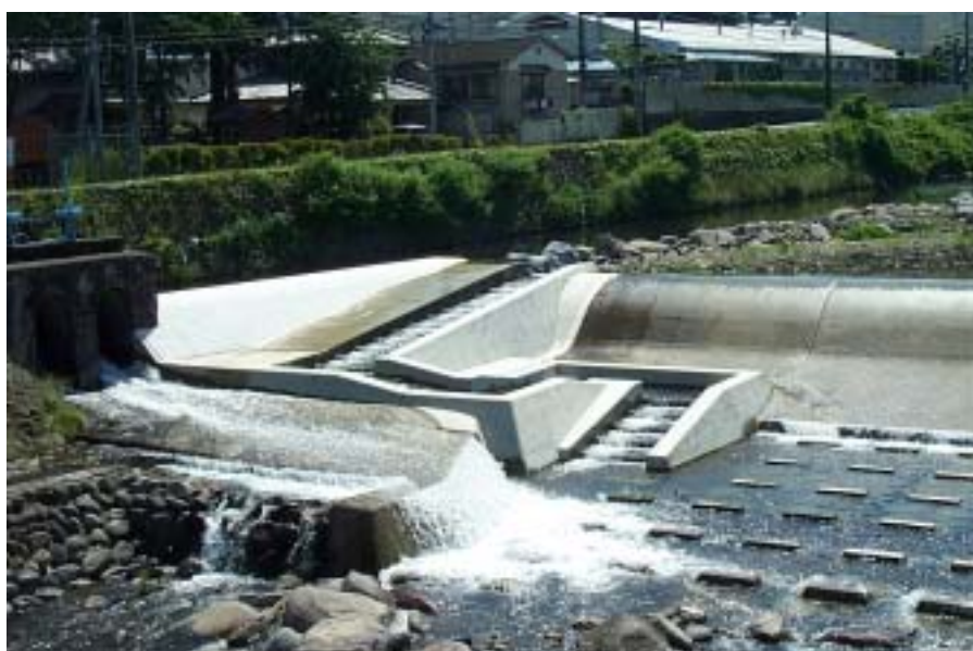
（平成 18 年 3 月に完成した魚道）
