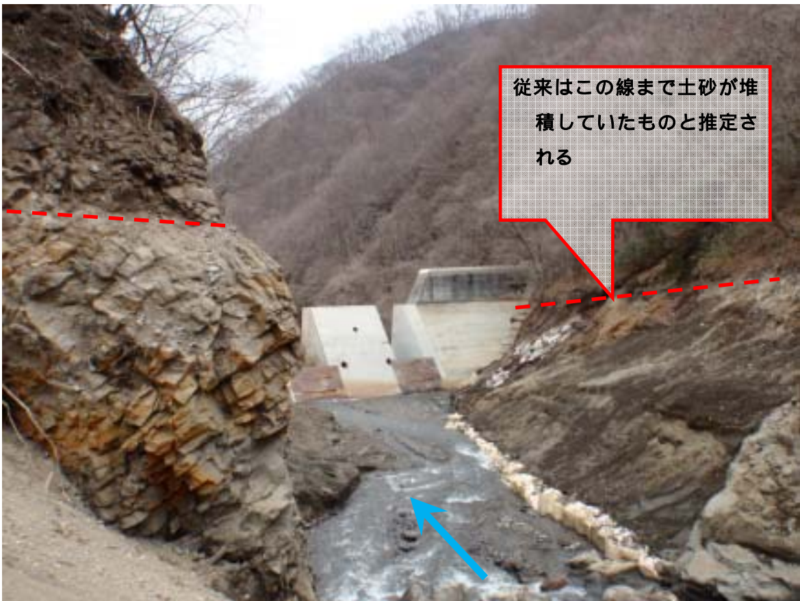
上流より砂防えん堤を見る。赤の破線は、推定土砂堆積位置。
