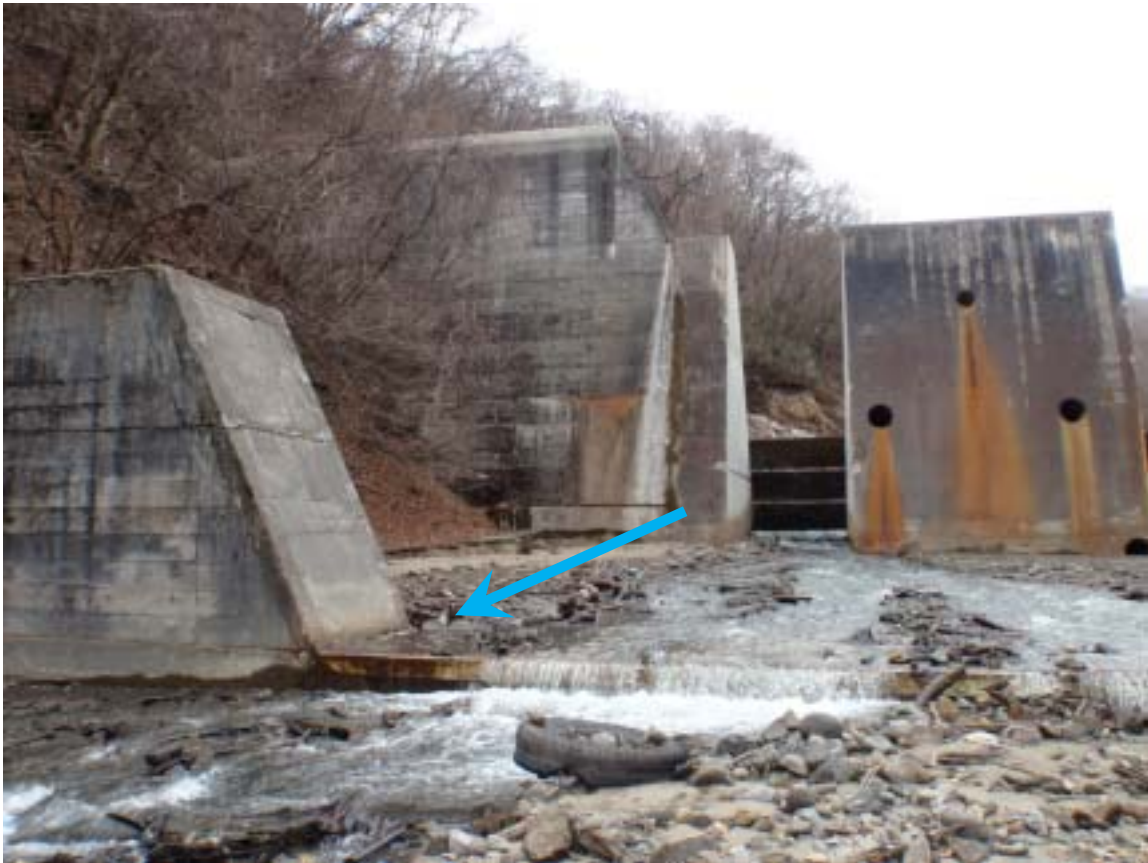
下流より（魚がえん堤の上流に移動できる）
