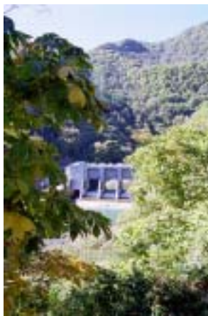
水上発電所取水口(利根川の橋データ表による)
