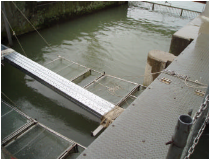
1号魚道出口の採捕用の金属網
